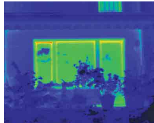
Nach dem sorgfältigen Einbau neuer Schüco Corona CT 70 Classic Fenster beweist die Thermografie den hohen energetischen Nutzen der Investition. Der ursprüngliche Energieverlust wird nahezu vollständig vermieden.
