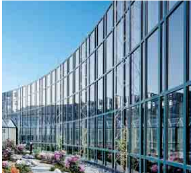
Verwaltungsgebäude Ennepetal, Deutschland Office building, Ennepetal, Germany
