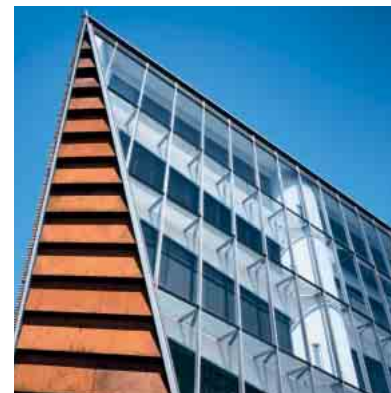
FW 50+ S, Rathaus, Hamar, Norwegen FW 50+ S, Town hall, Hamar, Norway
